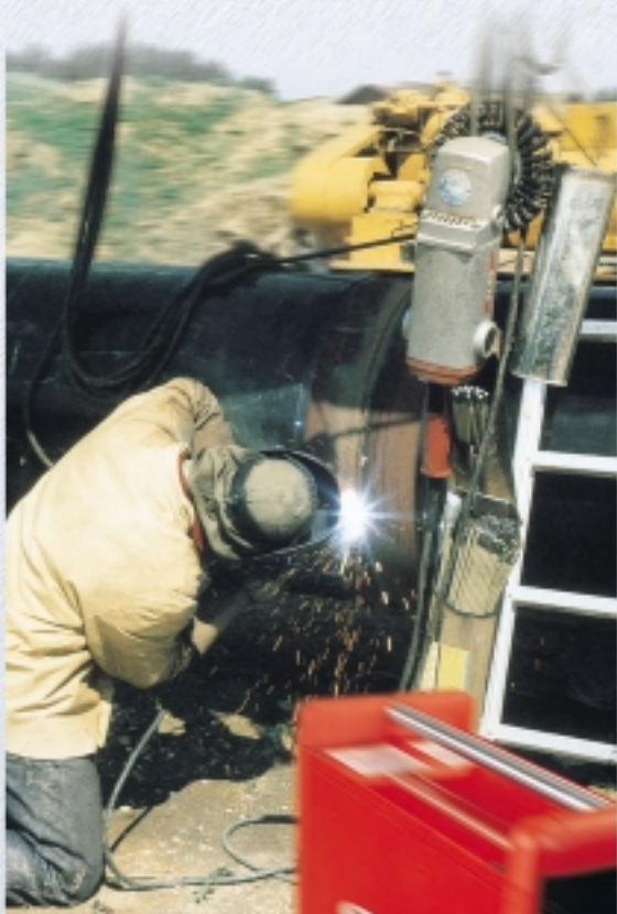
Des courbes caractéristiques optimales pour le soudage à l'électrode garantissent un arc électrique stable et une fusion optimisée.
